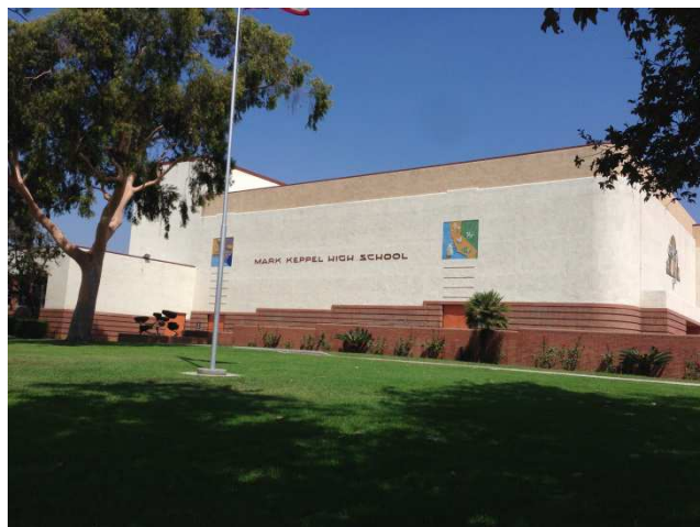
圖 1.1 本次參訪行程之一 Mark Keppel High School
