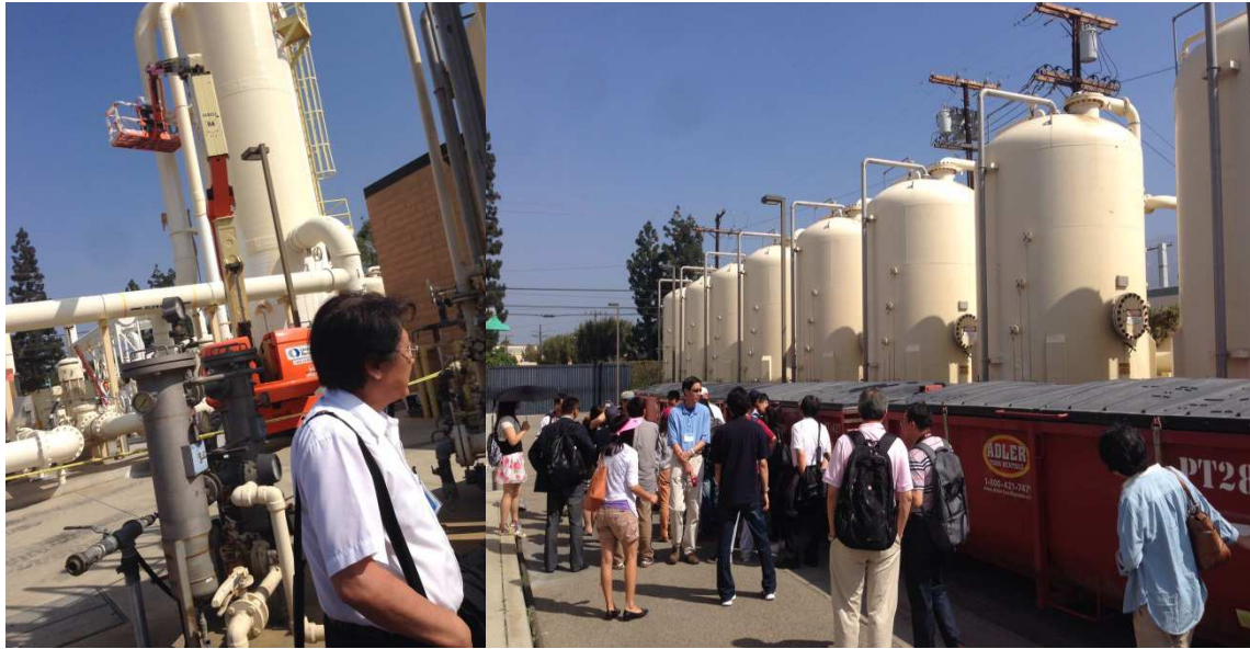
圖 3.3 經處理的水最終再消毒系統
