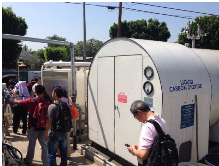
圖 3.5 利用乾冰製作小蘇打以調整進流水酸鹼值
