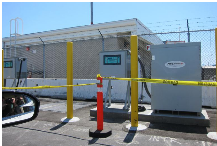
圖 69、洛杉磯港之電動卡車充電站設備
