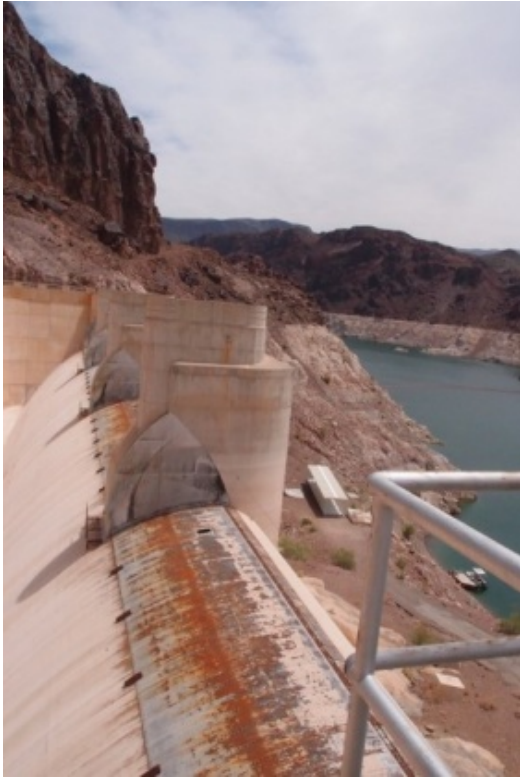
位於右壩基之溢洪道
