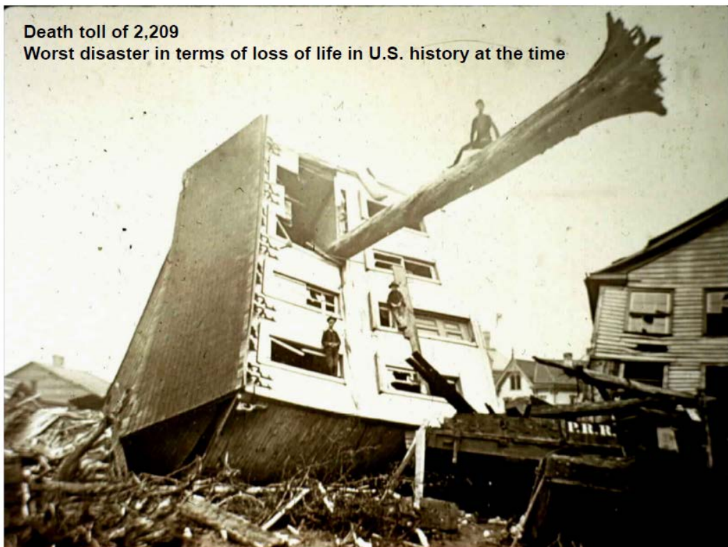
South Fork Dam潰壩造成2,209人死亡，房屋倒塌漂流木流入城鎮(摘錄自墾務局簡報)
