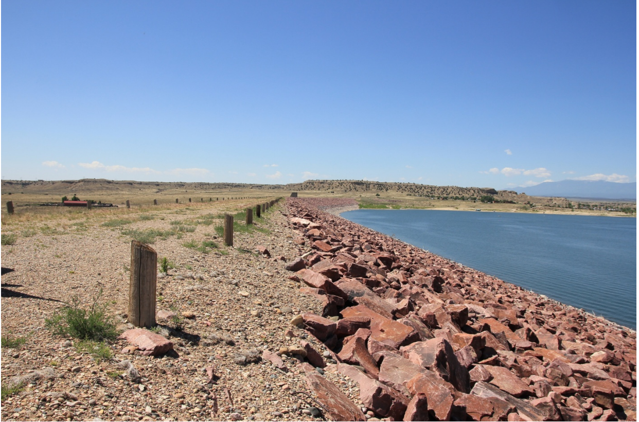
壩頂成排木樁觀測變位
