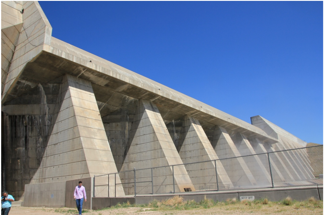
壩體混凝土扶牆壩
