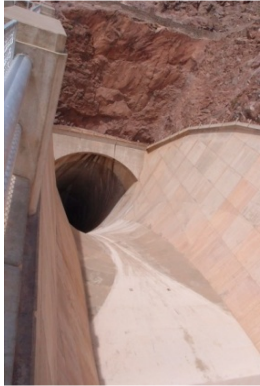
右壩基排洪隧道口
