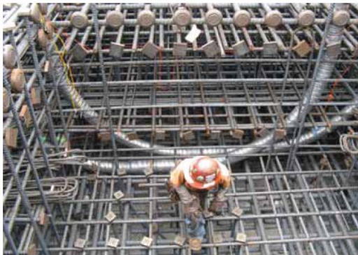
圖 39 預力套管貫穿基礎部分
