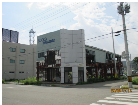
鋼構建築被海嘯衝破外牆
