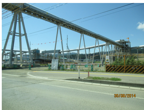
公共工程如火如荼進行中
