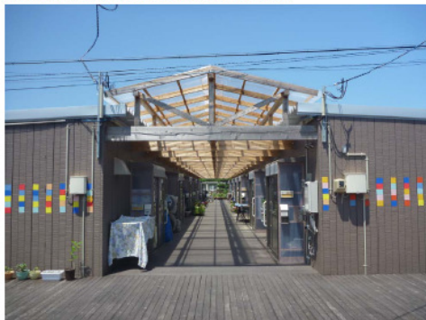
通常の仮設住宅とは異なり入口が対面型に配置された仮設住宅。ウッドデッキリアフリーにし、屋根をかけて人々の交流が進み、笑顔が生まれるように工夫した。
