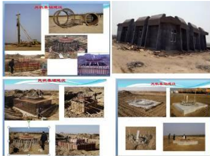
圖 6、施工中的山東東營市小型風力機測試場
