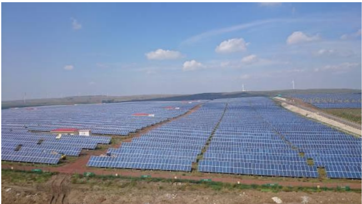
圖 23、國家風光儲輸示範電站太陽能發電站
