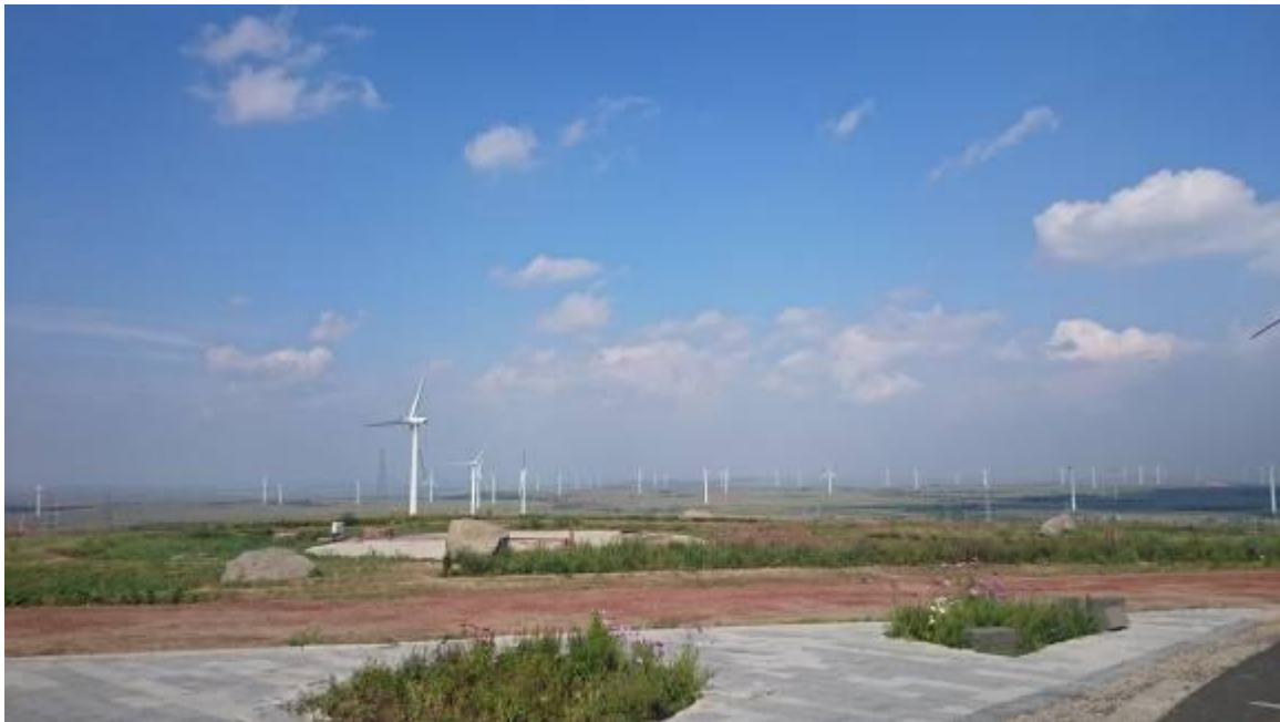
圖 21、中節能風力發電(張北)有限公司張北風場
