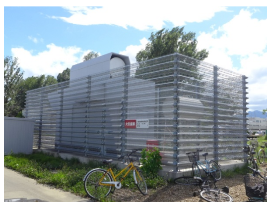
人畜共通疾病中心備源發電設備。
