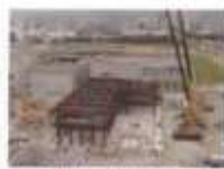
0002 建设正在建设的尖端医疗中心 (2002年9月)
