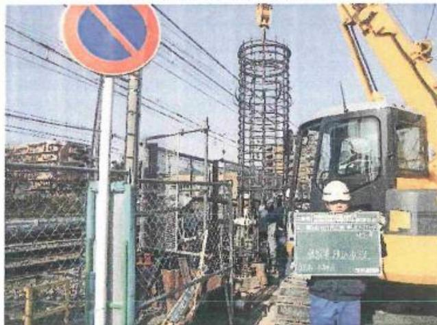
場所打ち杭鉄筋分割施工状況写真
