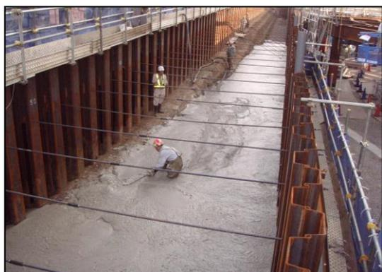
圖 3.7 氣泡混凝土
