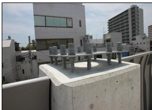
圖 2.16 電力桿基礎螺栓
