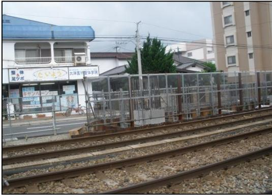
圖 1.18 施工防護措施(下構)
