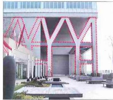
圖 6.5 結構柱位轉換
