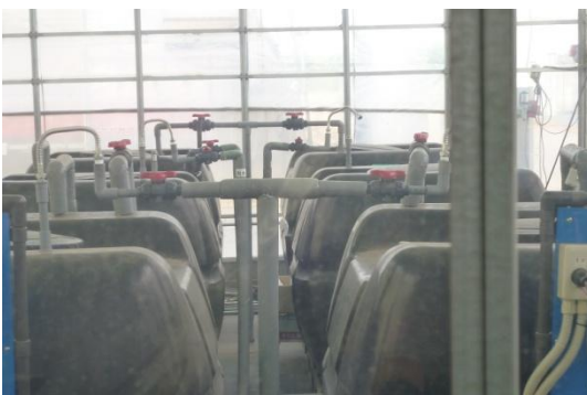
圖十八、千葉大學蕃茄水耕養液自動化配製系統
