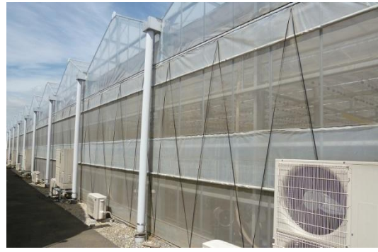
圖十五、太陽光利用型植物工廠夏季時需使用眾多空調降溫，蕃茄才能維持週年生產
