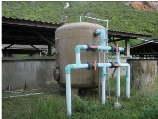
圖 11 海水過濾逆洗供水系統
