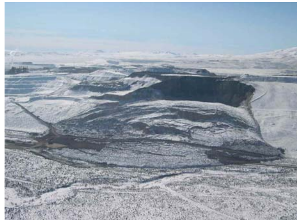
圖9 廢石堆置場坍塌滑移情形
