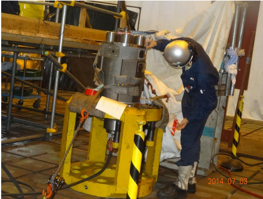
【圖廿五】 Ventilator Valve 水壓測試
