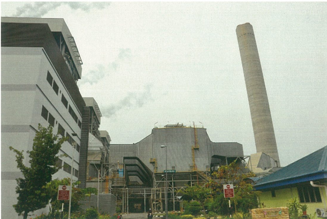
TNB 電力公司 Manjung 電廠運轉中的 3 部 700 MW 傳統機組
