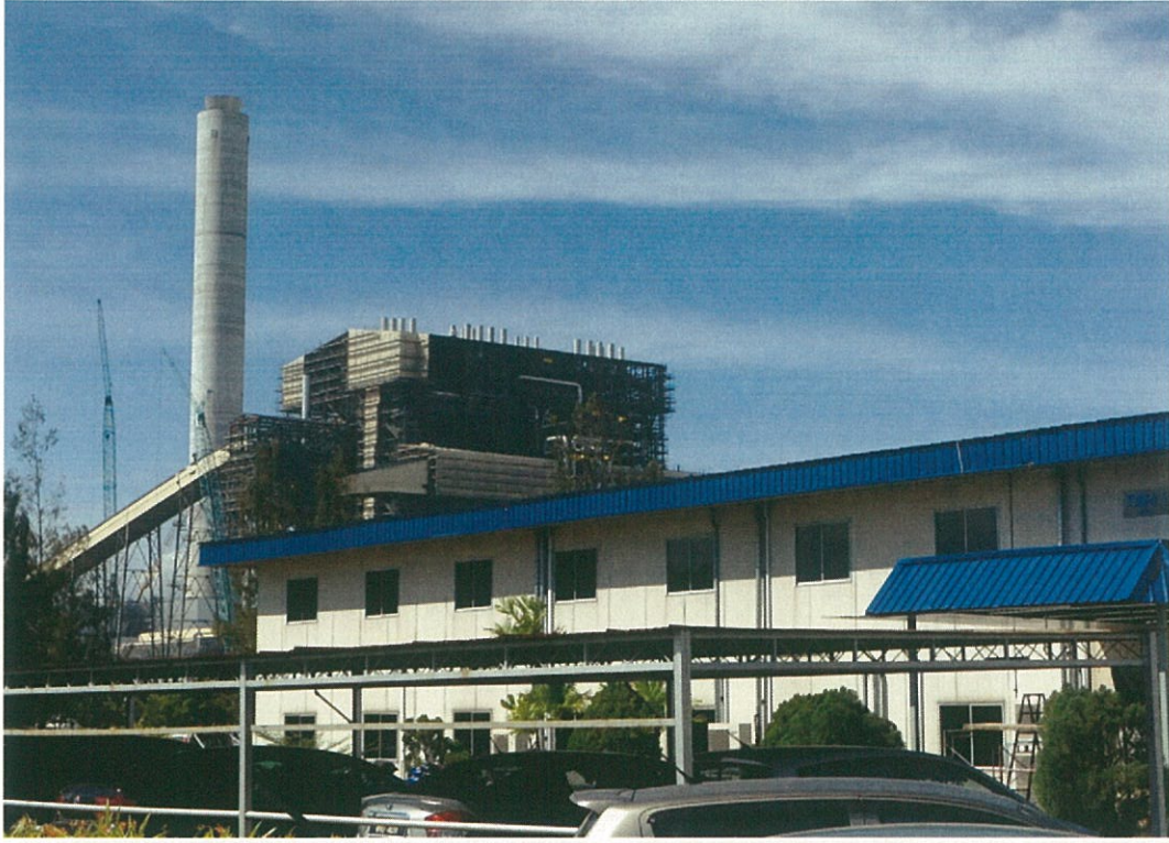
TNB 電力公司 Manjung 電廠興建中的 1,000 MW 超臨界機組
