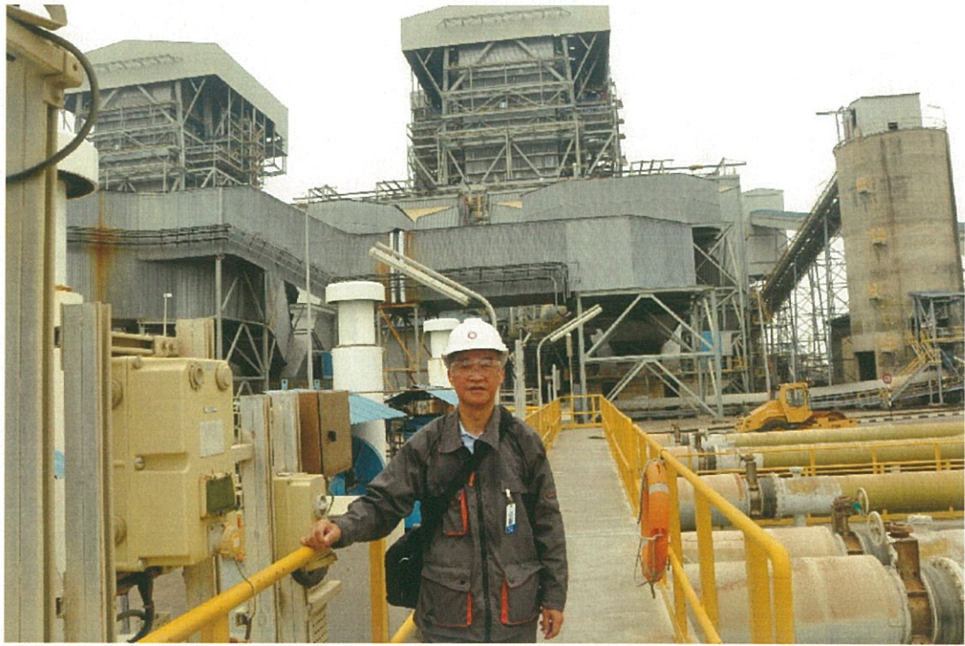
海水法脫硫現場設備(曝氣池)見習
