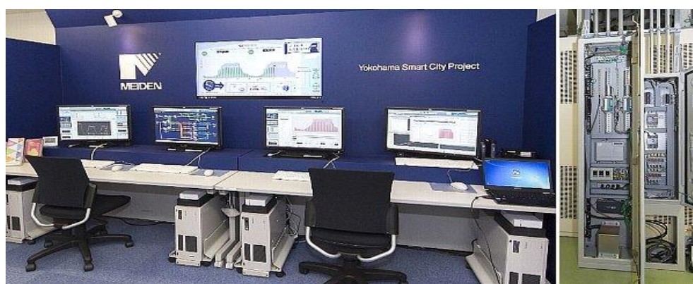
圖 10、智慧 BEMS 的中央監視系統與遙控中心
