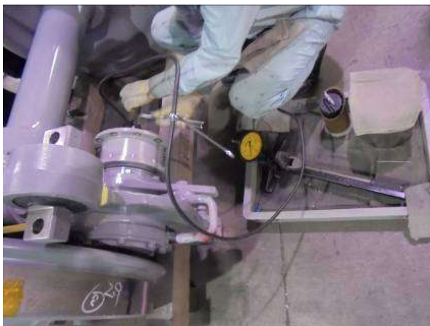
圖 3.28 撓性聯軸器安裝步驟圖 5
