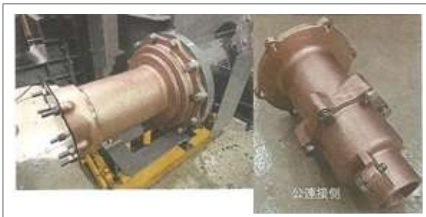
圖 2.29 主變壓器電纜頭連接圖
