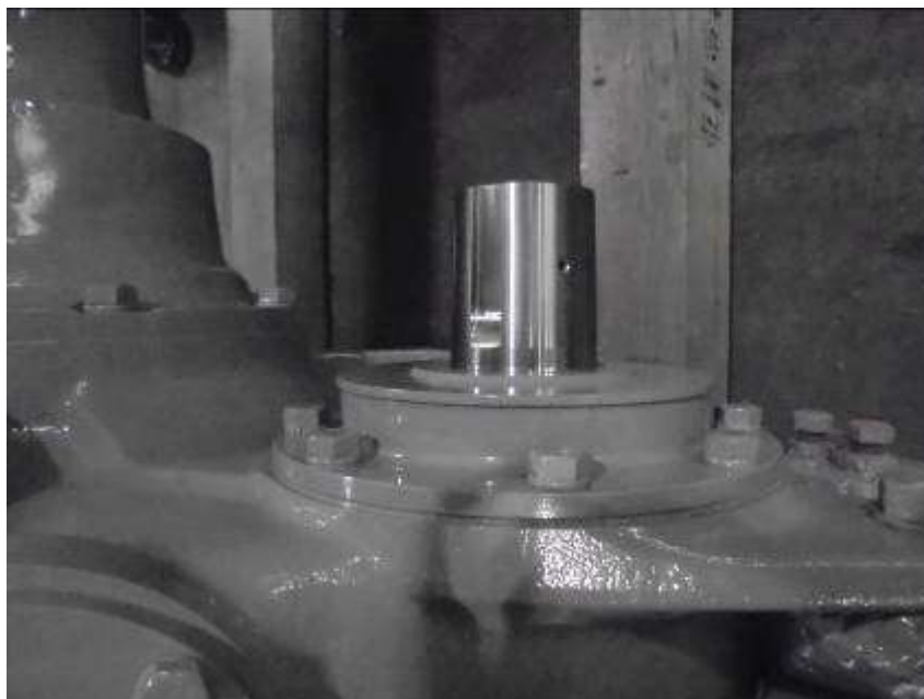
圖 3.24 撓性聯軸器安裝步驟圖 1
