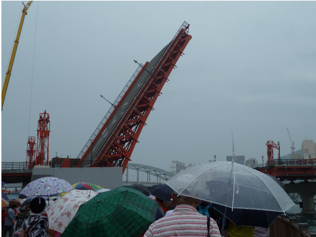
圖2.17 釜山南北港開合橋橋面開啟至高點照片
