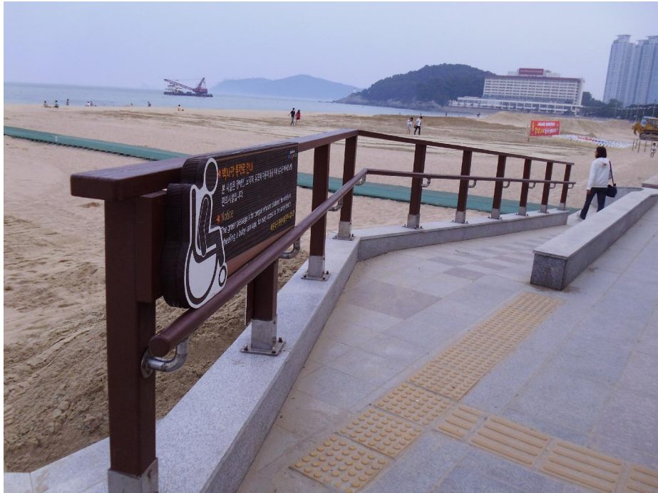
圖3.24 海雲臺沙灘無障礙步道入口緩坡設施
