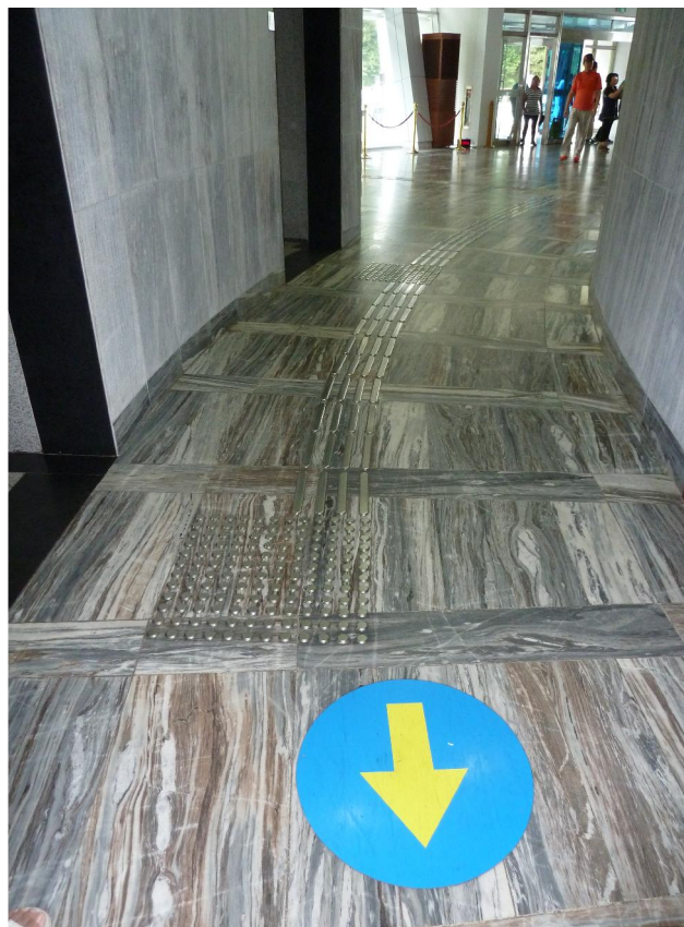
圖3.22 釜山海雲臺APEC會館地板無障礙導盲設施
