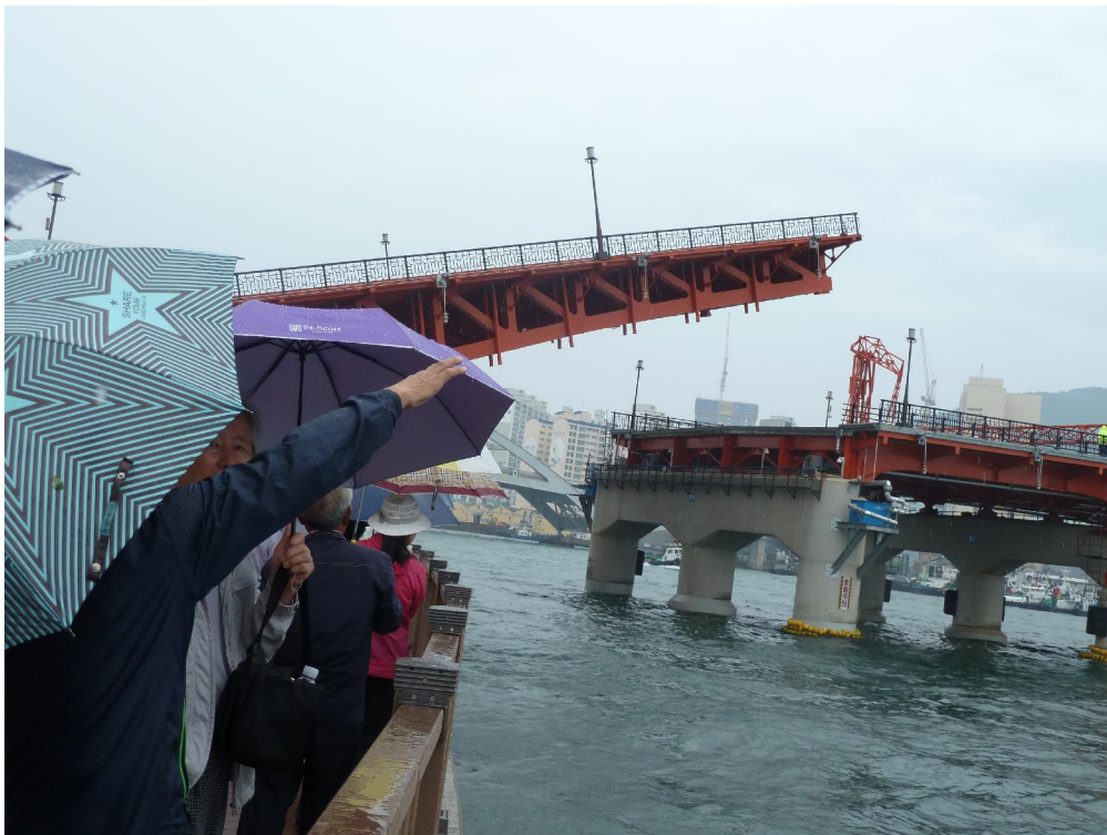
圖2.18 釜山南北港開合橋橋面下放照片
