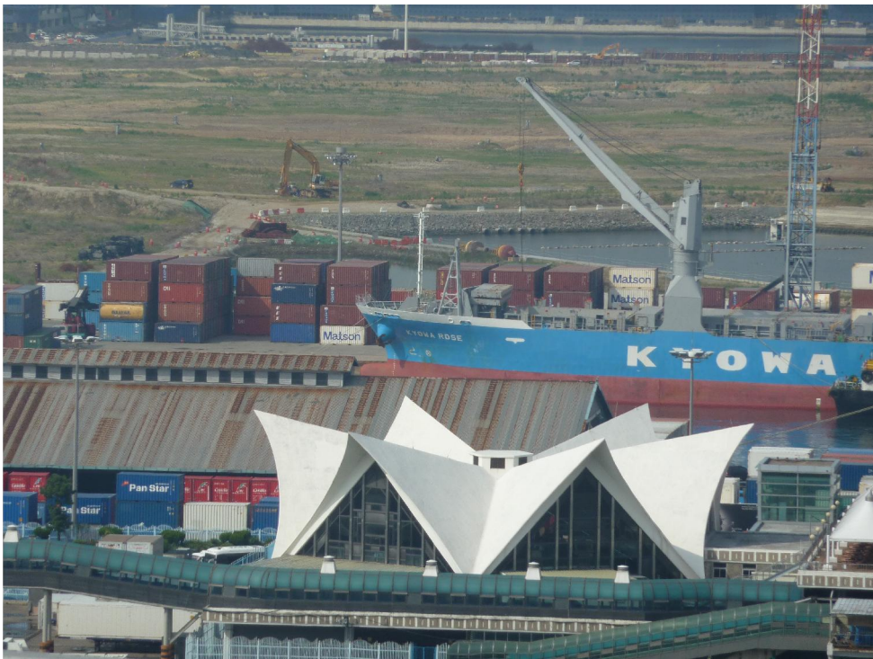
圖2.15 釜山港國際渡輪旅客中心遠景照片
