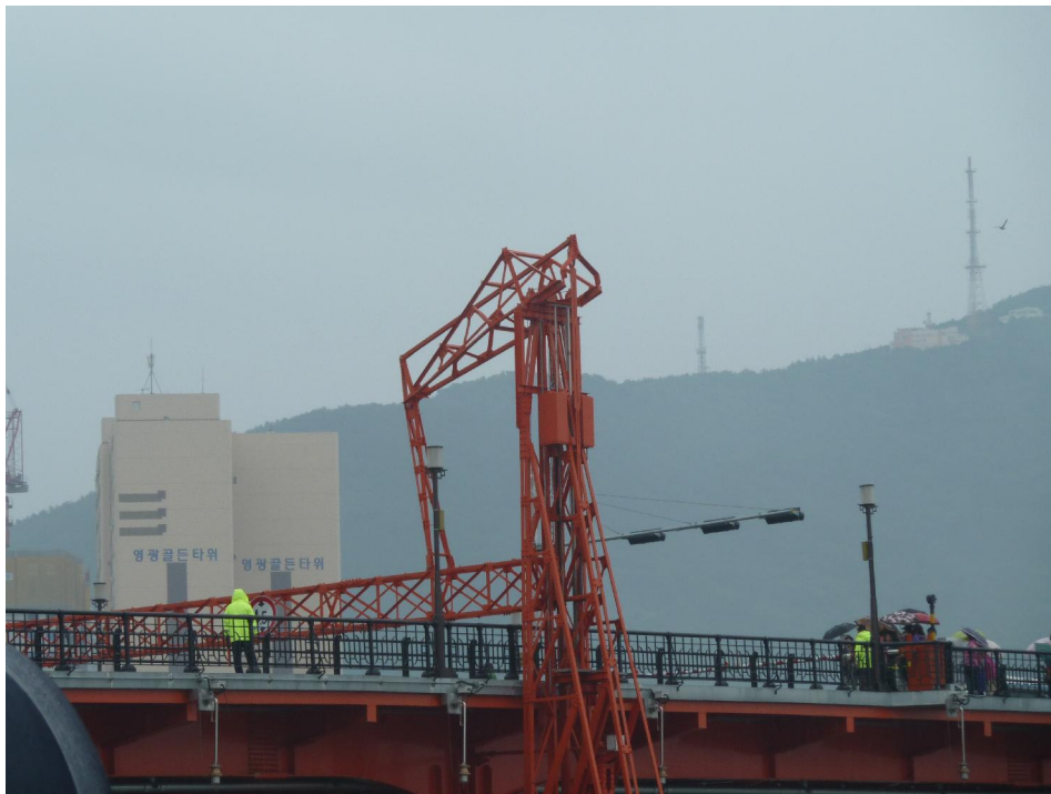
圖2.16 釜山南北港開合橋橋面交通柵欄下放照片
