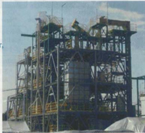
圖 9 Oji Paper 廠址建造日進料 1 噸之測試工廠
