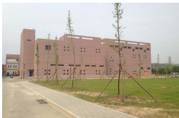
建设中的P3实验楼
