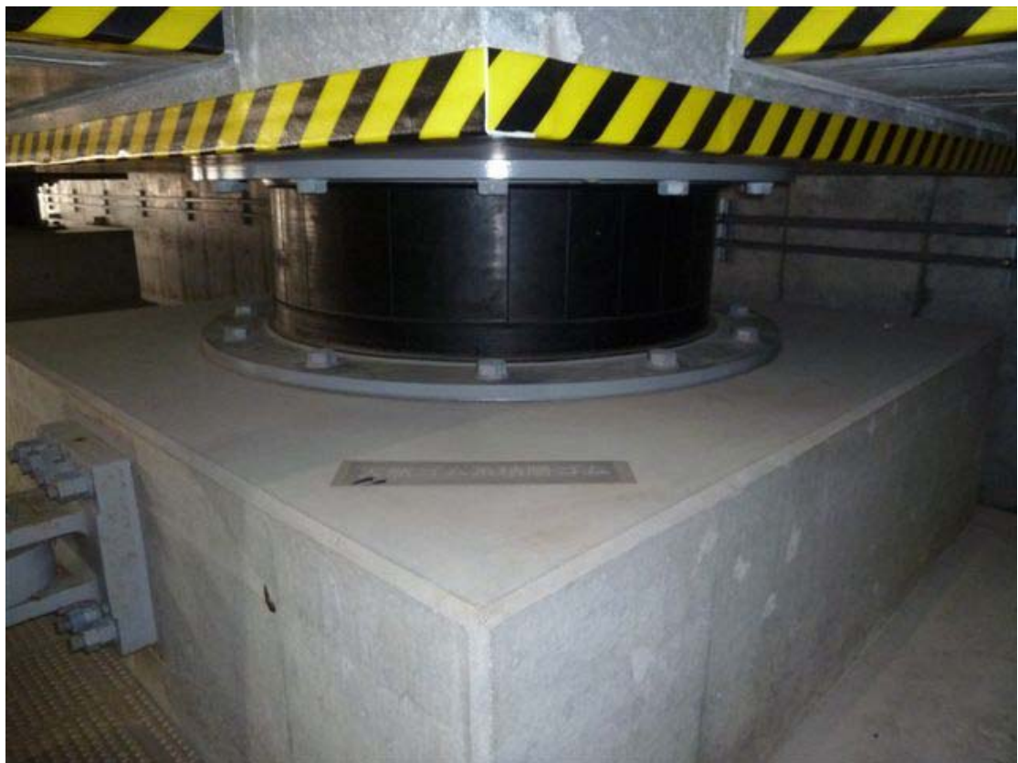
圖 3-2：濱岡核電廠免震建物基座
