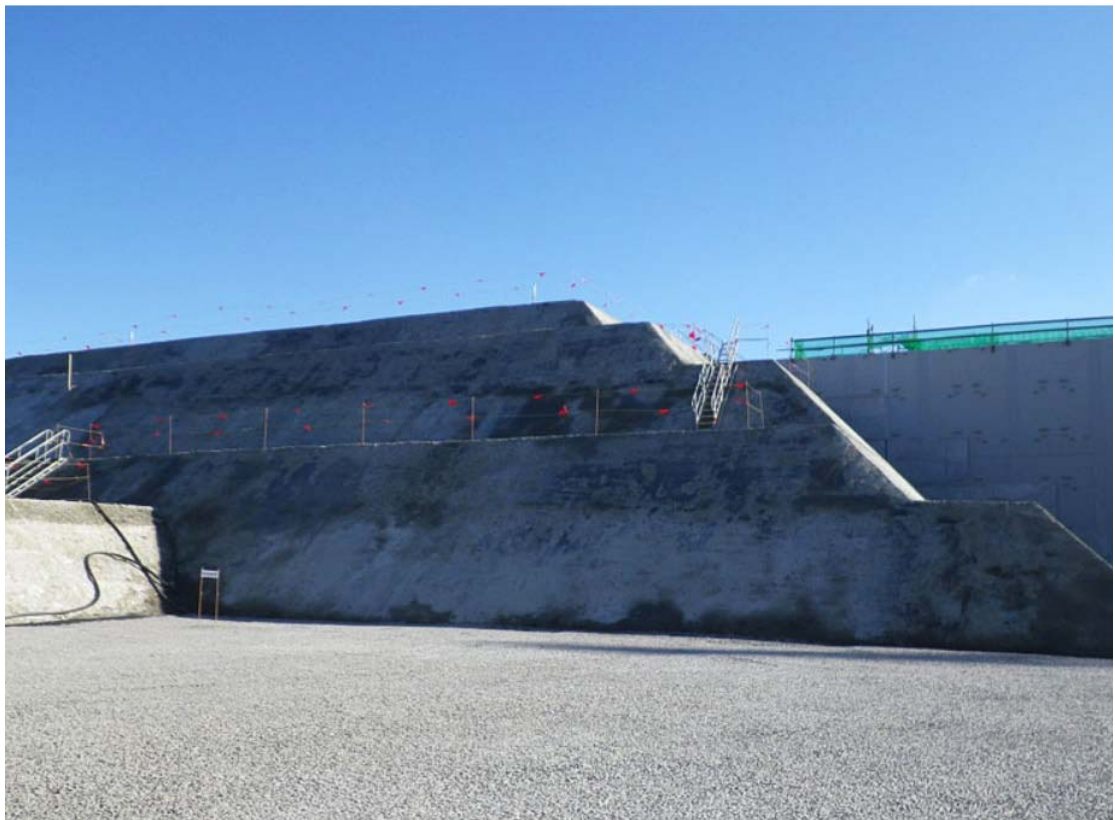
圖 3-6：防海嘯牆西側之水泥強化土堤
