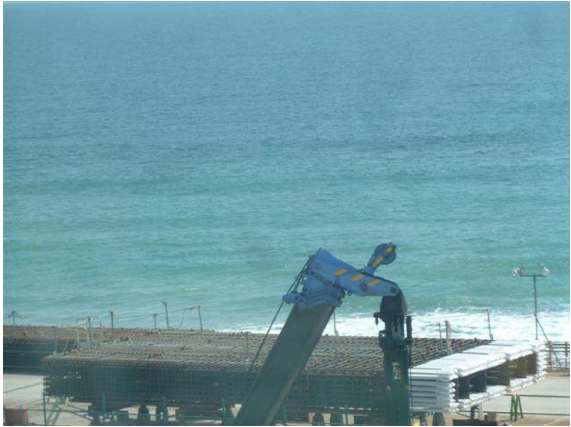
圖 3-5：濱岡核電廠海堤興建工程
