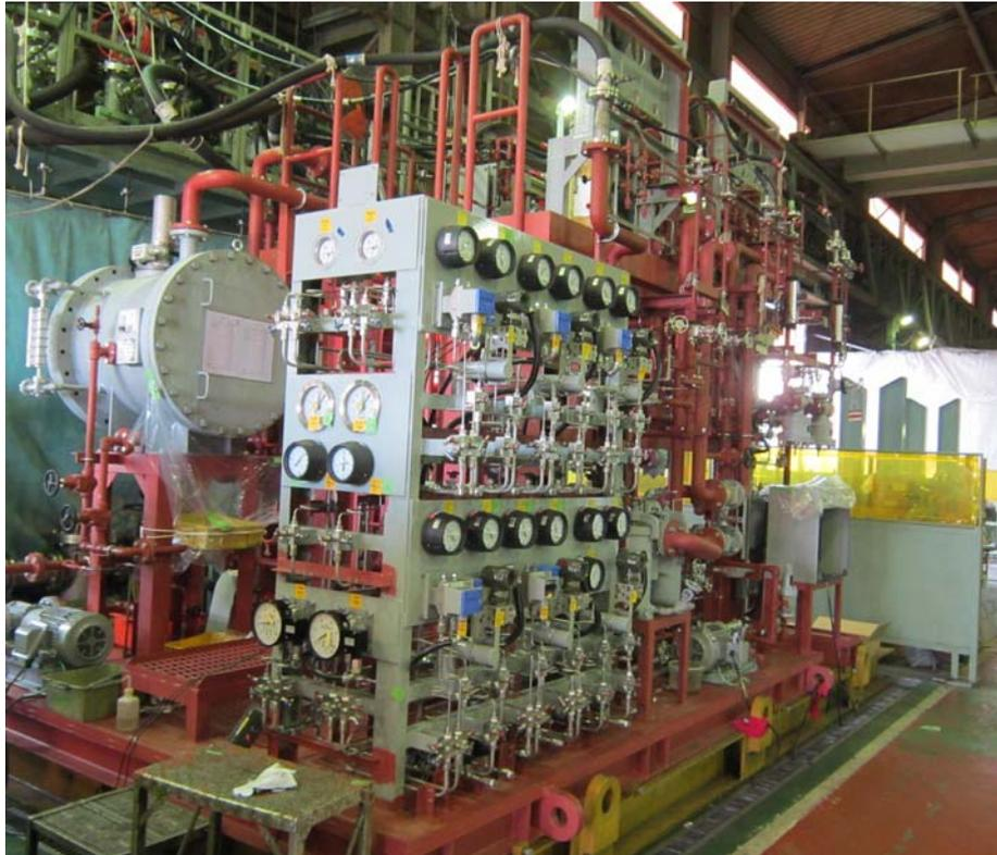
圖 2-1 林口新 2 機封油系統設備
