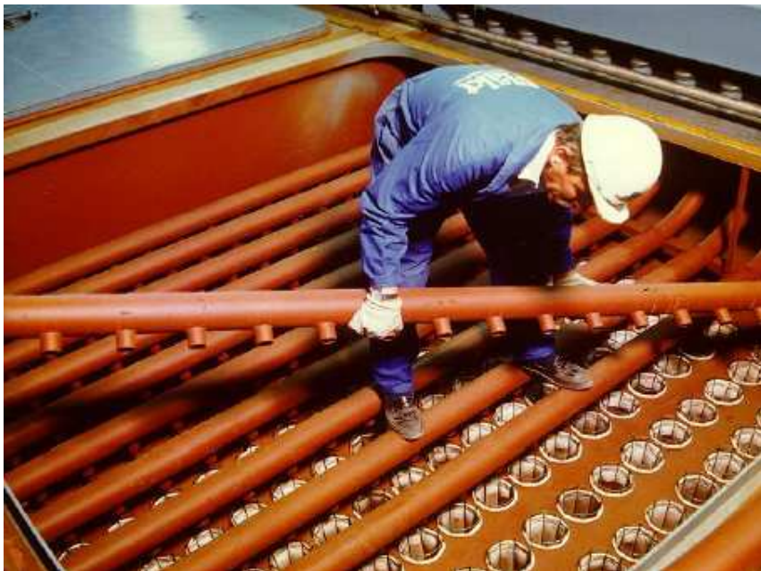
圖 24 噴嘴管拆除
