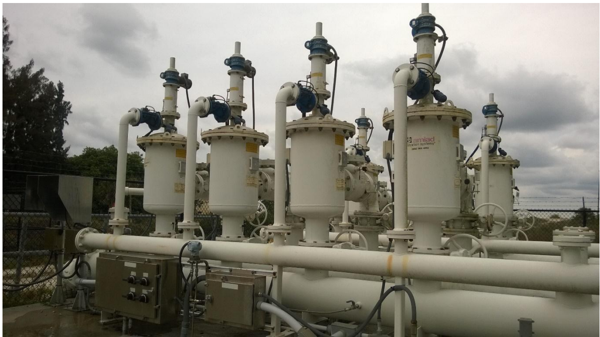
圖 30 ASR 地下水補注井抽水及過濾系統
