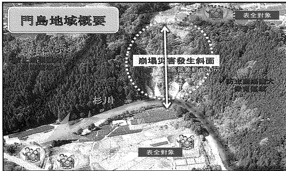
門島地區崩塌狀況(資料來源：簡報資料)
