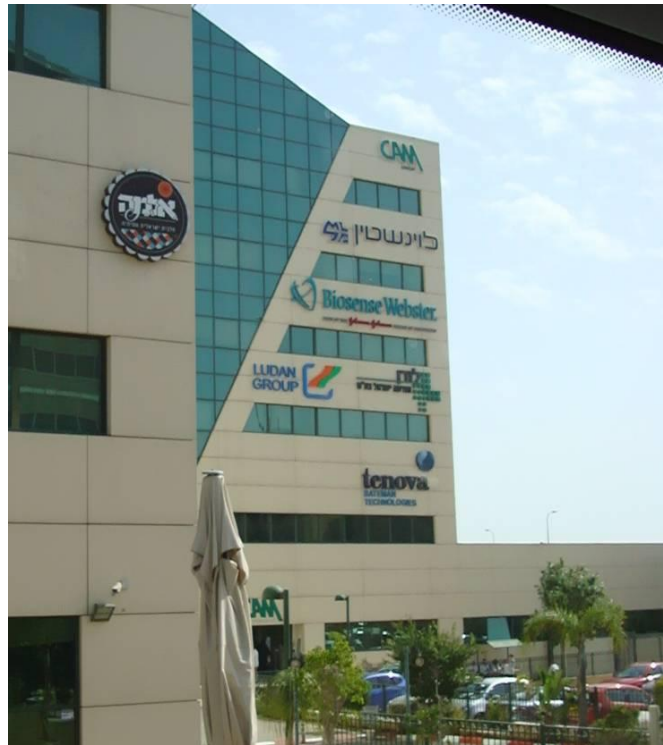
圖十三：位於 Yokneam City 的 Biosense Webster 公司外觀，由外牆 Logo 可知該棟大樓為多家公司共用
