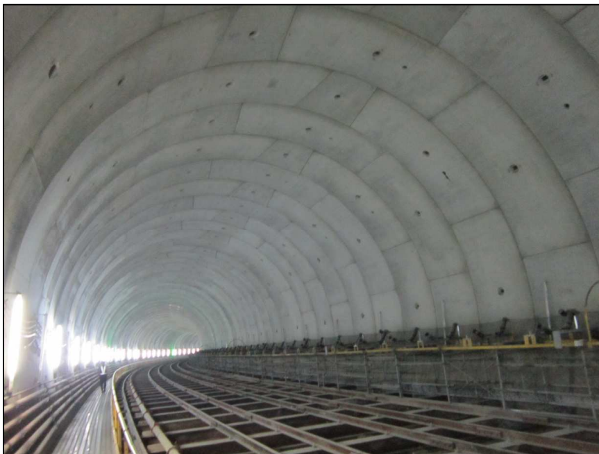
圖 26、大斷面洞道完成情形
