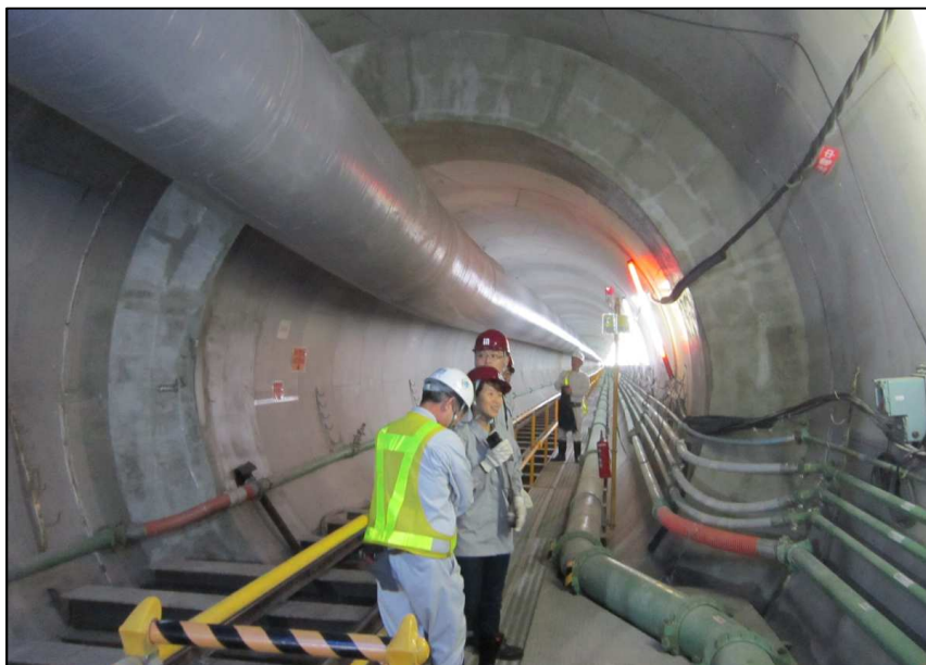
圖 20、變斷面(親子分離)銜接處
