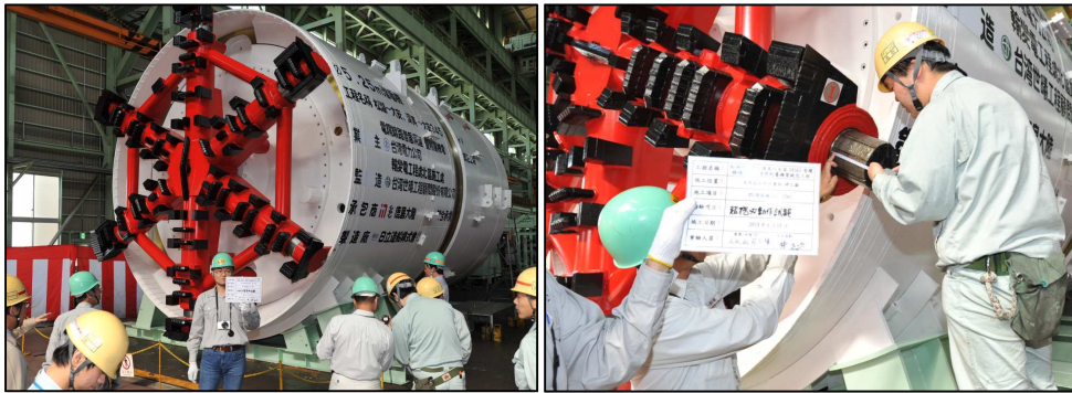
圖 31、切削盤及超挖刀動作確認
