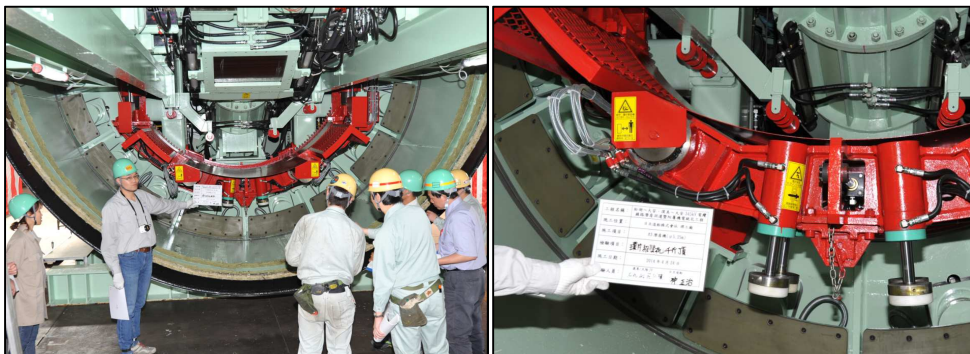
圖 33、環片組立裝置動作確認
