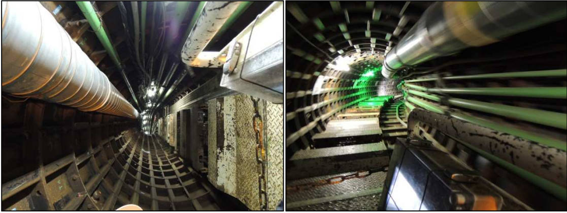
圖 10、全線鋼環片施工
