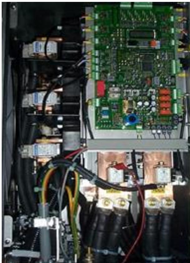
右圖為整流箱內的控制卡片，負責控制整流閘流體的觸發及相關元件間的匹配及訊號的傳送。維護人員也可於控制卡片上的EPROM視窗上查看相關故障訊息及參數設定。
