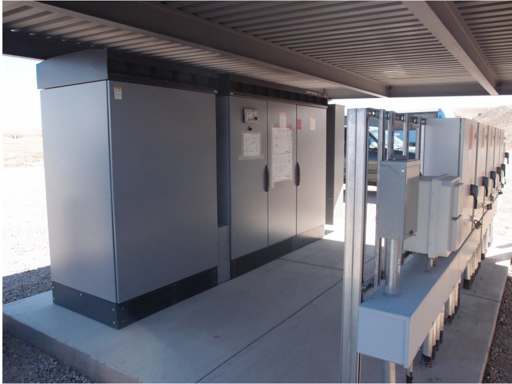
圖 4.21、EUBANK LANDFILL SOLAR ARRAY 聚光型太陽能電廠之直交流變電箱(SMA SUNNY CENTER)
