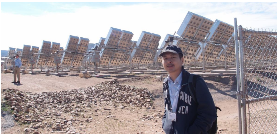
圖 4.20、EUBANK LANDFILL SOLAR ARRAY 聚光型太陽能電廠
