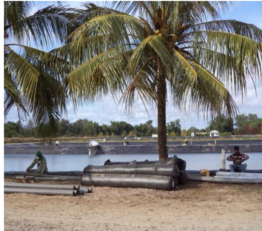
海水抽水管更新準備
