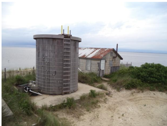
Cape Shore 保留古蹟試驗建築及水塔
