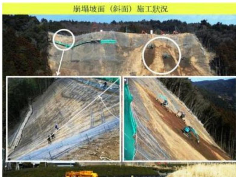
圖 3-6 崩塌坡面鋪築鋼網及無人化施工概況
