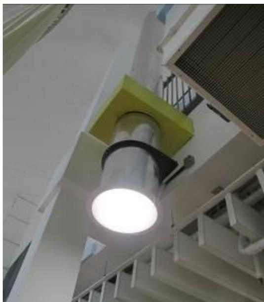
圖 102 利用導光管從屋頂引進照明之節能技術
