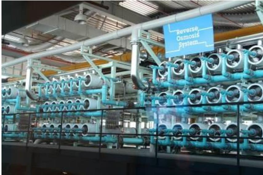
圖64 新生水工廠中使用之Reverse Osmosis System淨化設施
