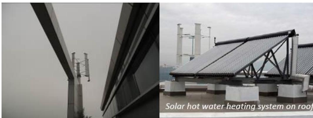
圖 112 Green18 綠景樓屋頂軸流式風力發電機組及太陽能熱水系統
