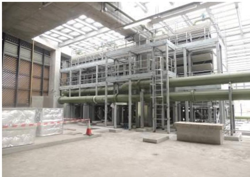
圖 138 啟德發展區區域供冷系統之淡水降溫系統
