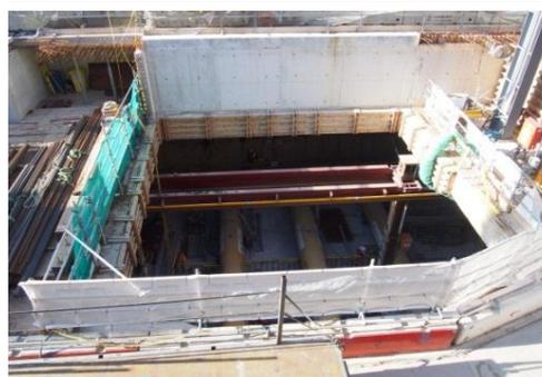
圖 3.1-4 參訪 CROSSRAIL 工地支撐鋼構-(2/2)
