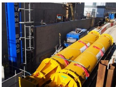
圖 3.1-3 參訪 CROSSRAIL 工地支撐鋼構(1/2)
