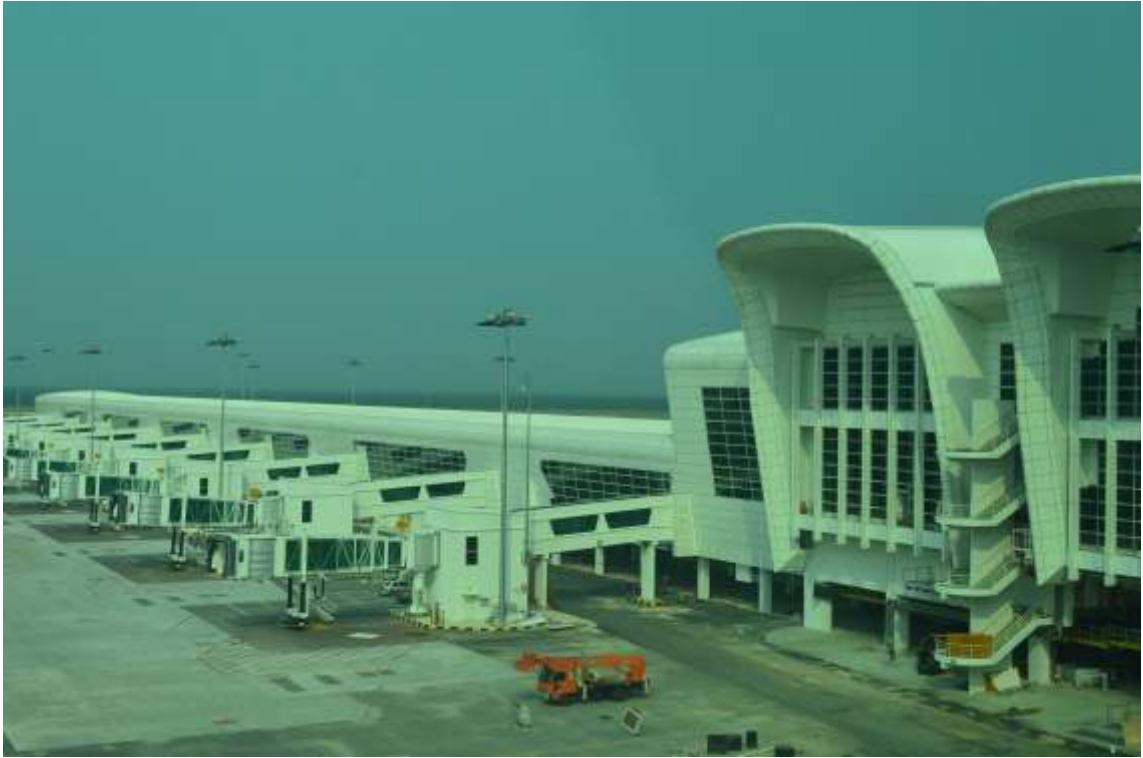
圖 1、吉隆坡第二航廈外觀
