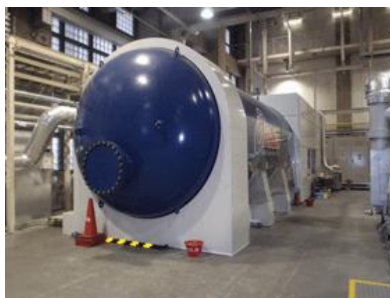
圖 8 MHI-加壓型 SOFC 以及微渦輪複循環發電系統實體[9]
