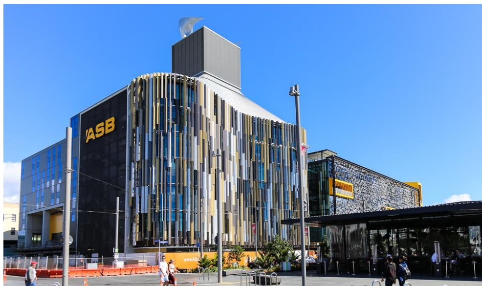
圖 6 ASB North Wharf 大樓 16
