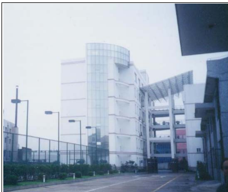
圖 8 國家消防裝備質量監督檢驗中心
