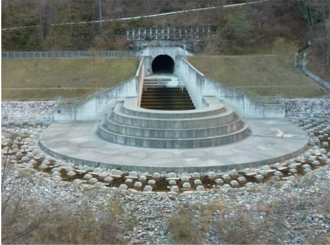
圖 38 美和水庫排砂隧道出口圖
