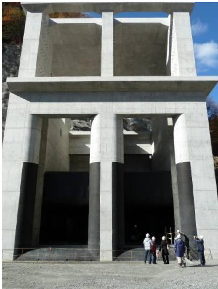
圖 33 小渋水庫排砂隧道入口閘門圖
