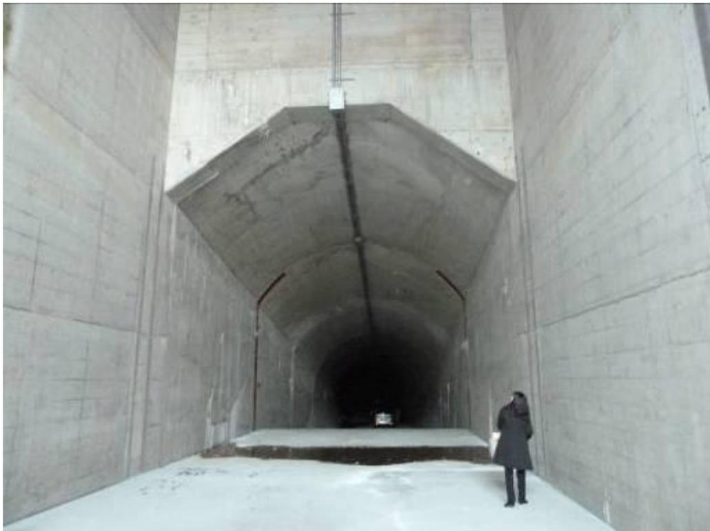
圖 37 美和水庫排砂隧道入口圖
