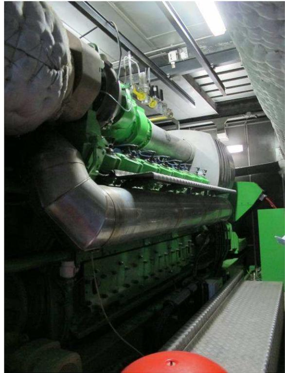
圖18、Vitapep設置汽電共生設備
