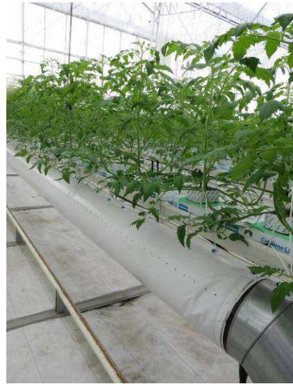
圖32、植槽下方的通風管，讓空氣均勻的分佈於溫室中：
