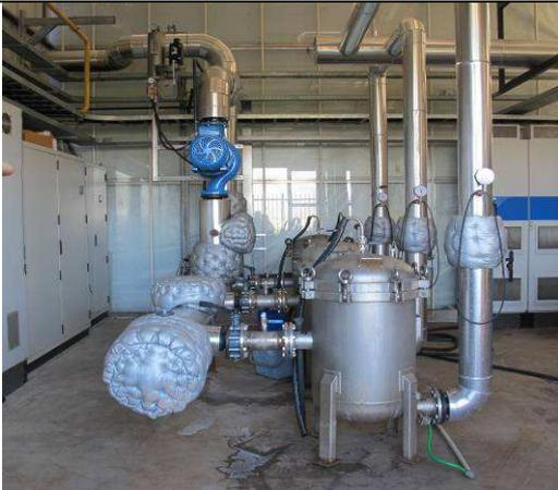
圖15、地熱系統之氣體分離槽，將地下抽出氣體分為可燃及二氧化碳。
