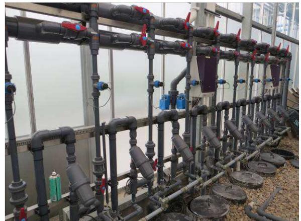
圖22、溫室區的溢流水經由管路回收，在經過一連串的過濾、殺菌後可與灌溉水混合再利用。
