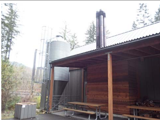
生質能源設備外觀
