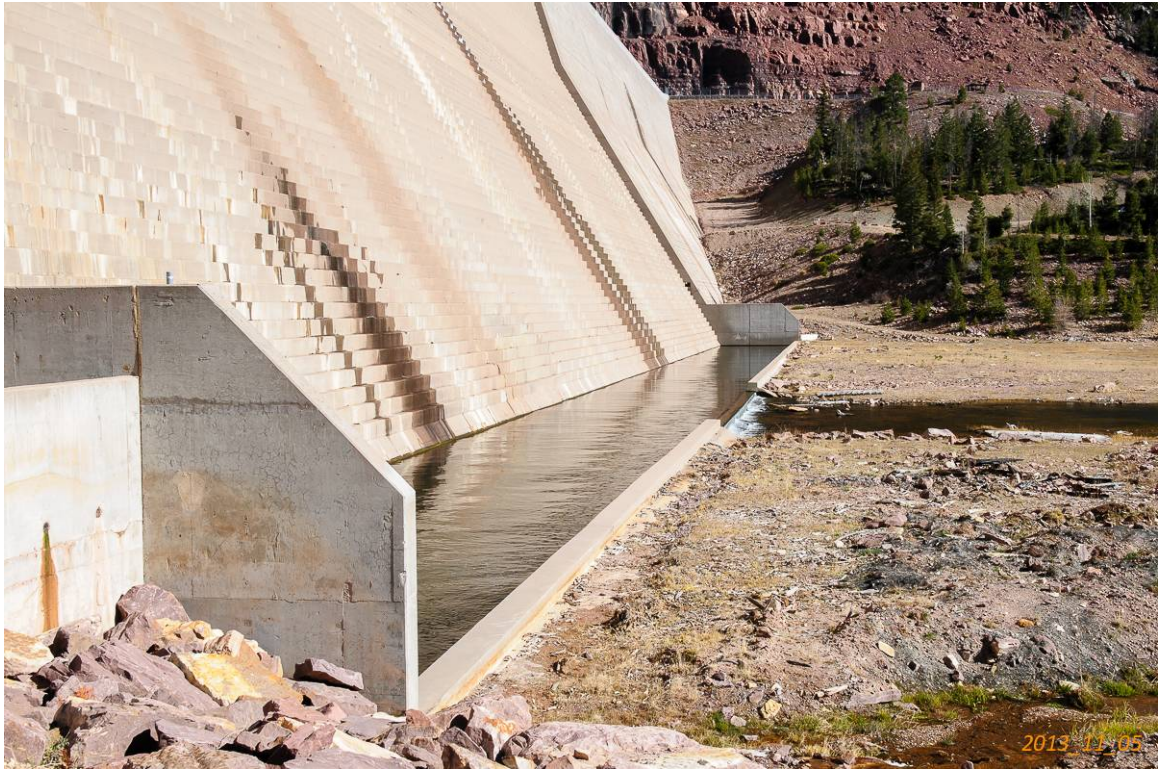
圖 4.23 Upper Stillwater Dam 階梯消能溢洪道與靜水池
