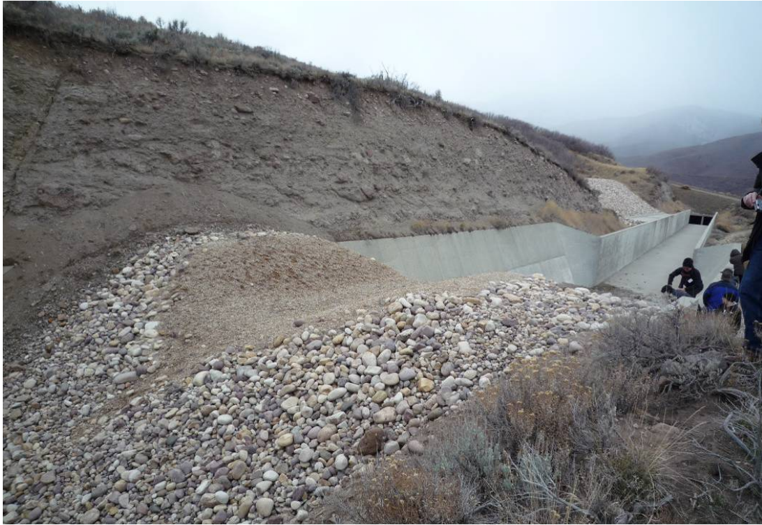
圖 4.13 Jordanelle Dam 溢洪道 fuse plug (往下游看)
