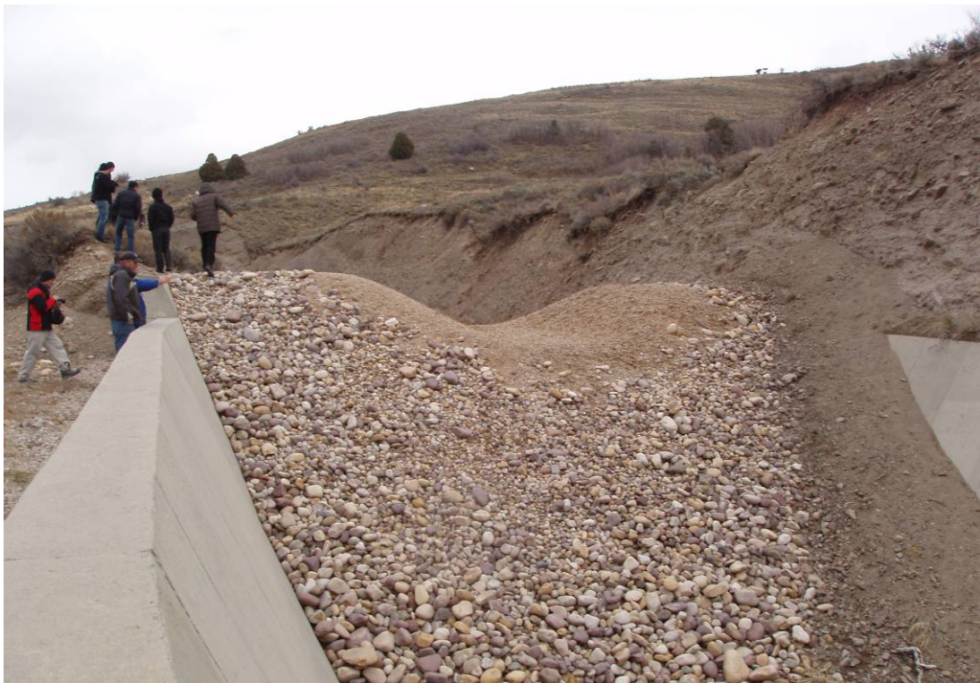
圖 4.12 Jordanelle Dam 溢洪道 fuse plug (往上游看)
