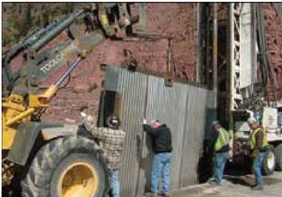
圖 4.22 不鏽鋼阻水浪板吊放入槽溝
