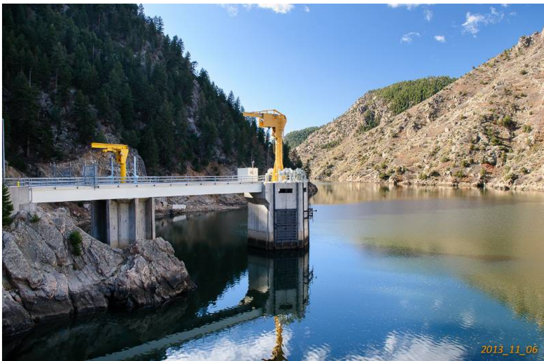
圖 4.27 Strontia Springs Reservoir 分層取水工
