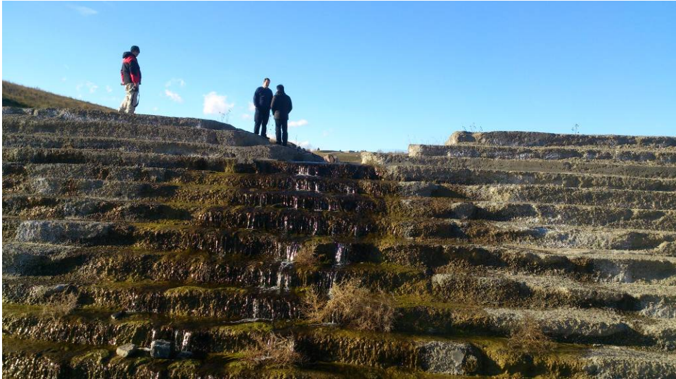
圖 4.38 RCC 跌水工一景
