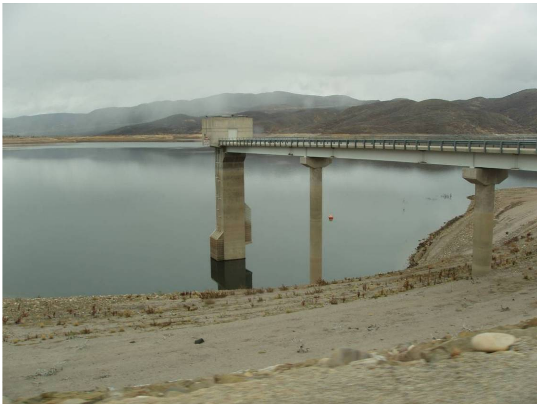
圖 4.10 Jordanelle Dam 分層取水工
