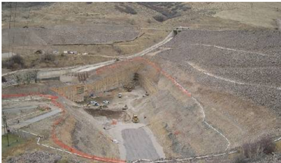
圖 4.15 Deer Creek Dam 壩址基礎 Shear key 開挖完成 ( http://www.slcdocs.com/utilities/NewsEvents/news2003/news11182003.htm )
