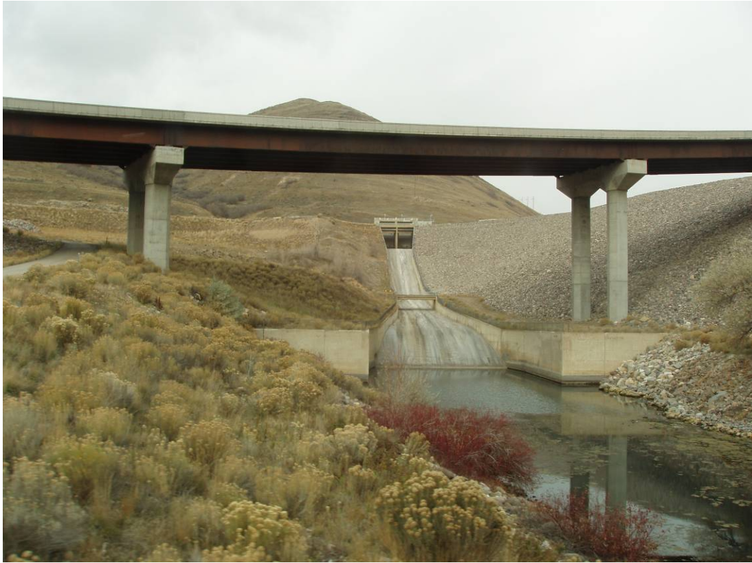
圖 4.16 Deer Creek Dam 溢洪道、壩下游面及 189 號公路
