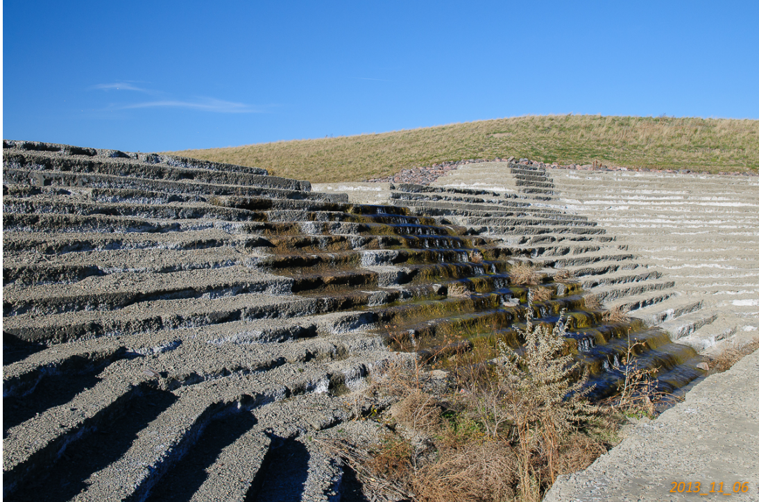
圖 4.37 第 7 座 RCC 跌水工
