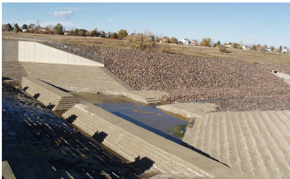
圖 4.35 溢洪道下游靜水池
