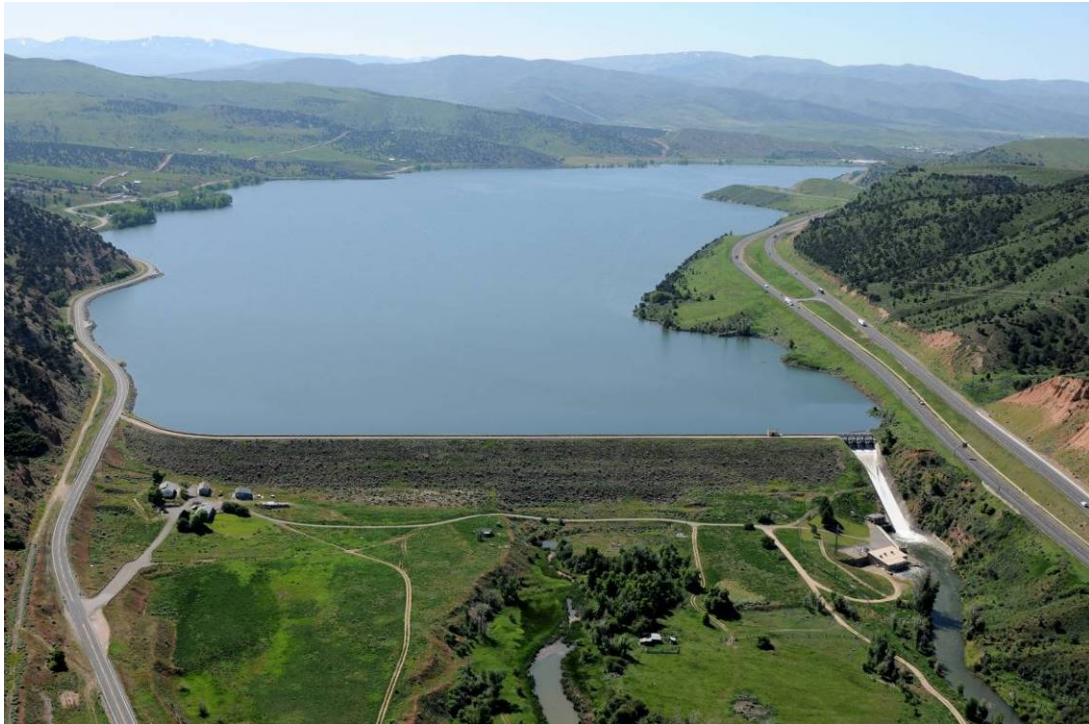
圖 4.2 Echo Dam (更新前)
