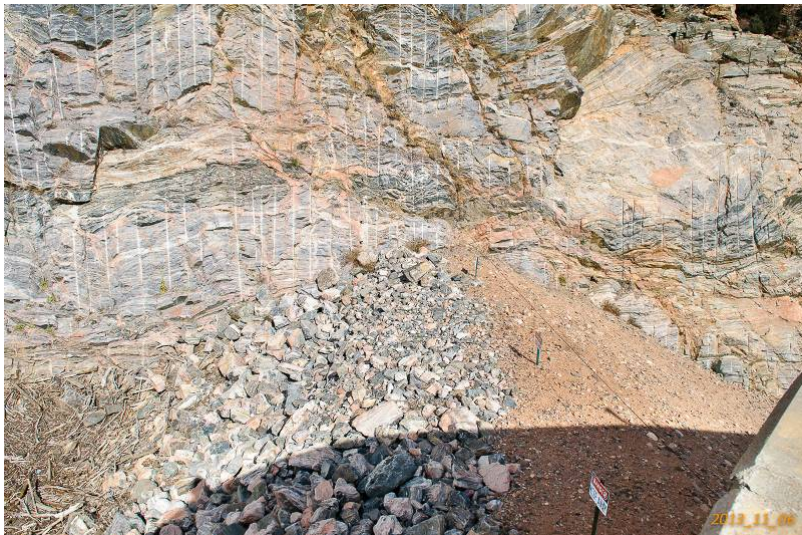
圖 4.29 左壩墩輔助溢洪道之 Fuse plug
