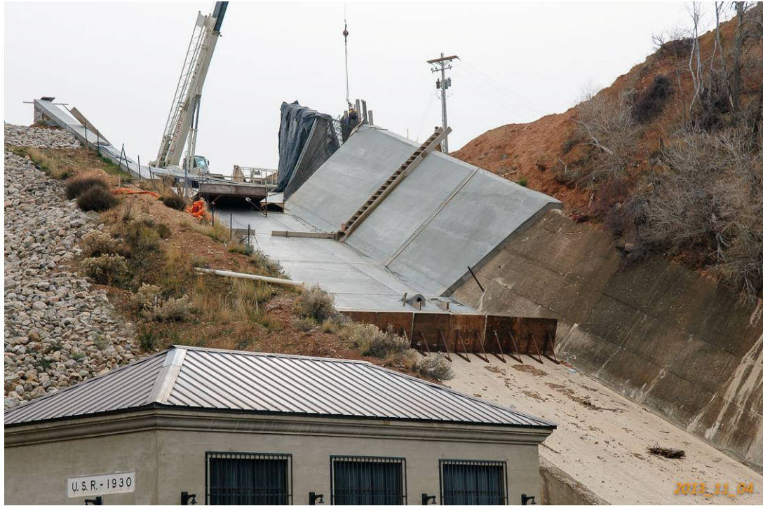
圖 4.7 Echo Dam 溢洪道更新改善(陡槽)
