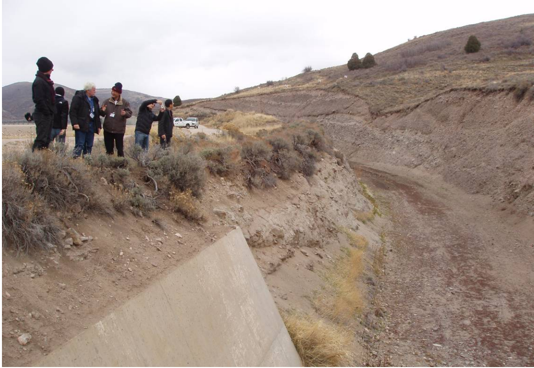
圖 4.11 Jordanelle Dam 溢洪道入口段(無襯砌)
