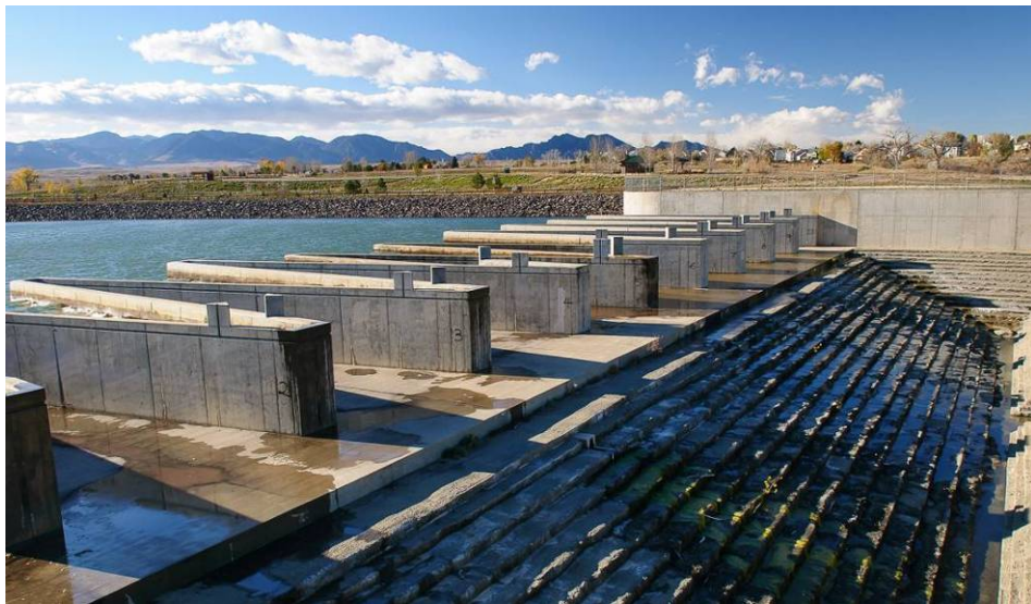
圖 4.34 鋸齒堰溢洪道(10 齒)
