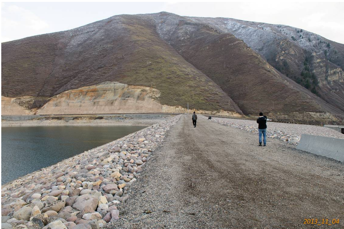
圖 4.17 Deer Creek Dam 壩頂
