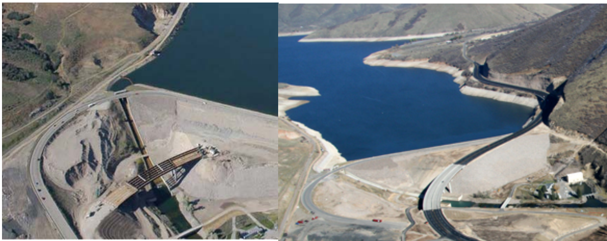
圖 4.14 Deer Creek Dam 改善施工中及完成後照片(墾務局提供)
