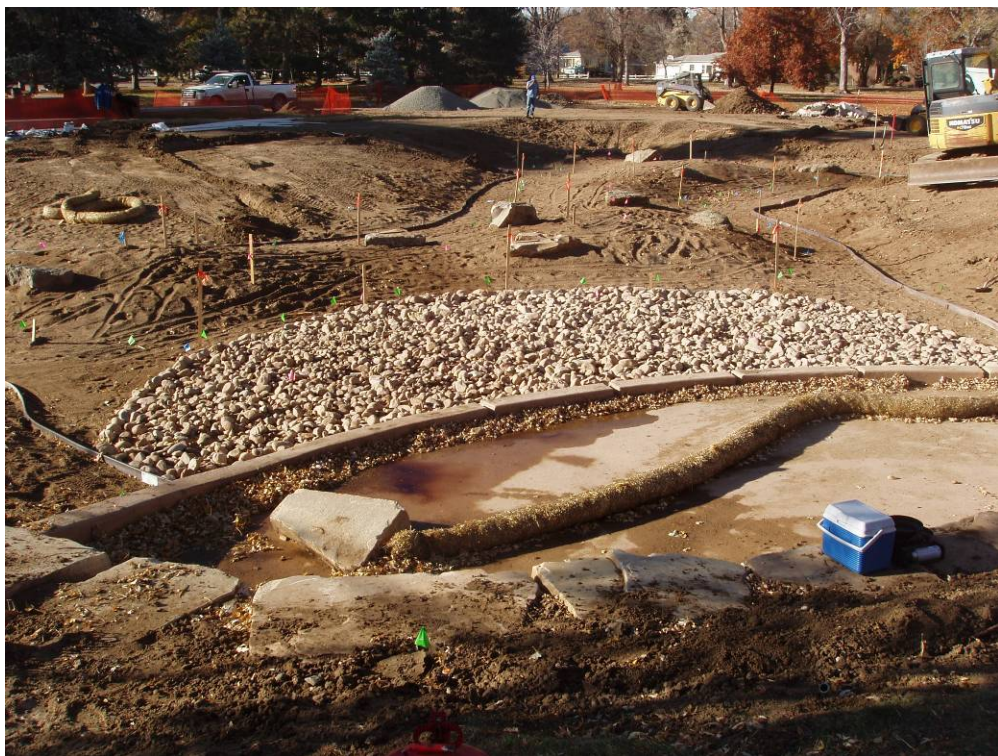
圖 4.46 LID 與公園設施結合施工
