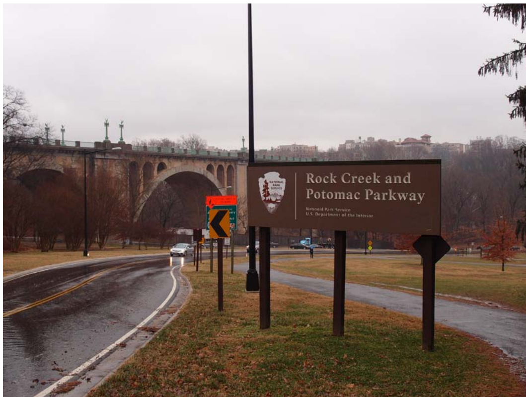
圖 5-5 Taft Bridge 現況照
