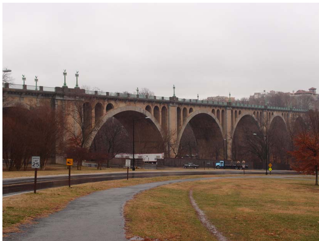
圖 5-6 Taft Bridge 現況照
