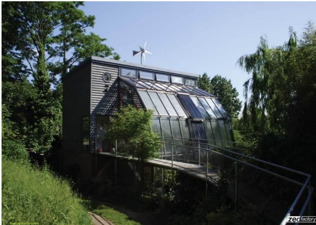
圖 31、ZEDfactory 希望之屋 (Hope House)
