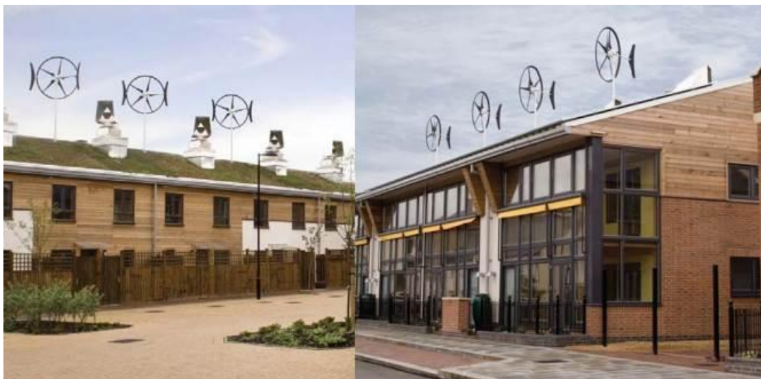
圖 33、北安普頓聯排住宅(Upton RuralZED)
