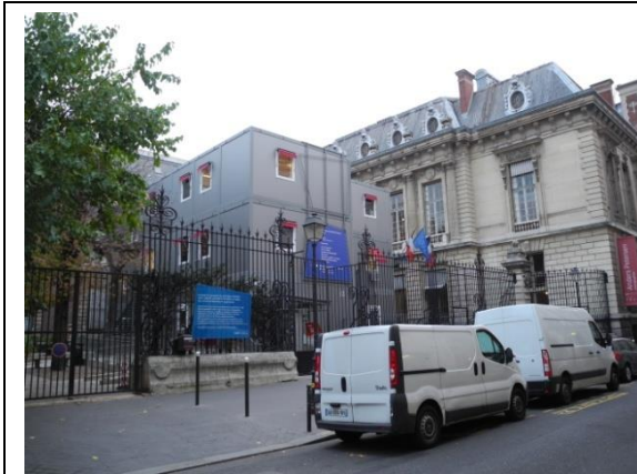
法國國家圖書館外觀，因部分建築整修中，加建工作室供暫時使用。
