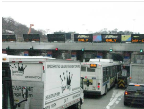
圖 2.48 高速公路收費站
