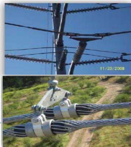
以上鐵配件經熱迴圈試驗後，在 ACCC 於高溫下運轉，鐵配件溫升大大低於導線本體溫度，而且經過 100~1000 次不等的熱迴圈試驗後，鐵配件兩端電阻值變化符合標準要求，握力測試耐張和接續鐵配件均未出現滑移現象。
