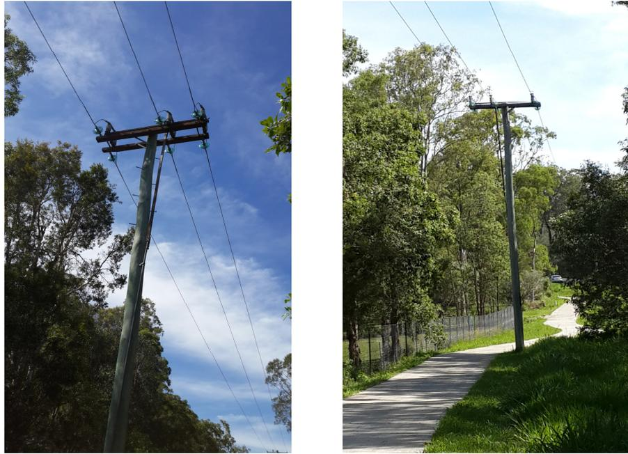
圖 4-10 Energex 電力公司在電壓調整器前後桿均安裝分段開關(DS)
