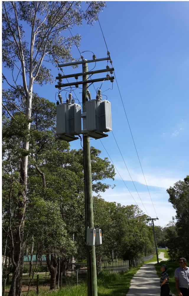
圖 4-9 Energex 電力公司調壓器安裝現場
