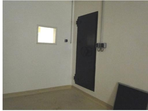
圖12.實驗動物舍內動物房的觀察窗口與內部出入口
