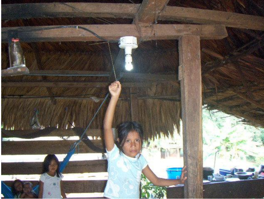
圖 19 巴拿馬偏遠地區安裝太陽能供電系統供給室內照明情形
