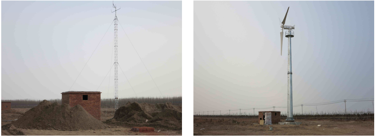
圖 4、東營中小型風力機沿海測試場部份風機塔架及測風塔已完成並開始測試
